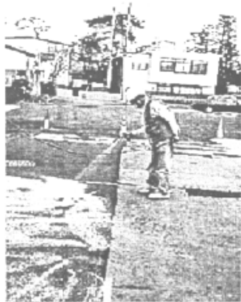
图 7 喷涂的具有光催化效能的“光路”
